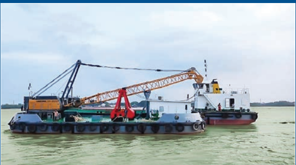
မြေတူး(၂)ရေယာဉ် (26M Grab Dredger)
