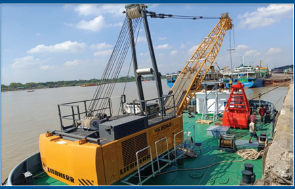
မြေတူး(၃)ရေယာဉ် (25M Grab Dredger)
