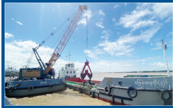
မြေခံ(၃)ရေယာဉ် (170m3 Split Hopper Barge)
