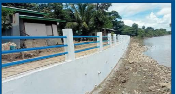
မြေထိန်းနံရံ(Retaining Wall) (ကျောက်ကြီးစီ/ သံကူကွန်ကရစ်နံရံဖြစ်ပါသည်)
