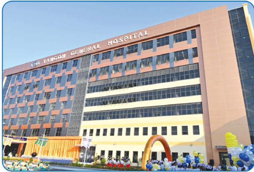
ရန်ကုန်ပြည်သူ့ဆေးရုံကြီး (၇)ထပ် ကုသဆောင်သစ် အဆောက်အအုံကို တွေ့ရစဉ်
